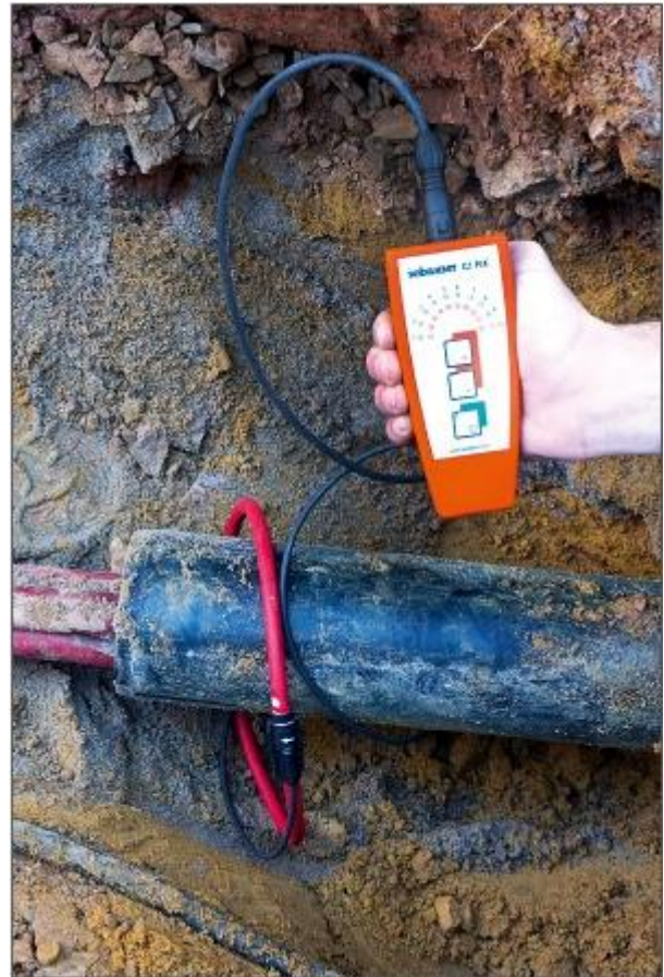
Anschluss des Ausleseempfängers
