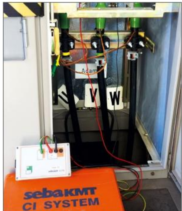
Einspeisung am Kabel
